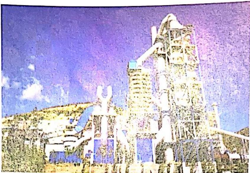
垃圾分类回收体系，使得水泥企业能够根据废弃物的不同属性进行分别处理<sup>[7]</sup>。首先分类回收城市生活垃圾，然后经过一系列预处理工艺，生产出高能源利用率的RDF，作为水泥窑的替代燃料使用。
